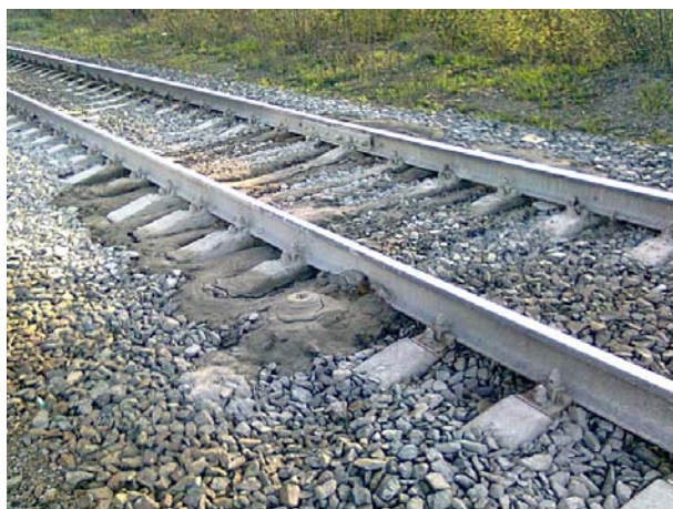
Рис. 1. Разжиженный балласт на протяжении семи шпальных ящиков (выплески)
