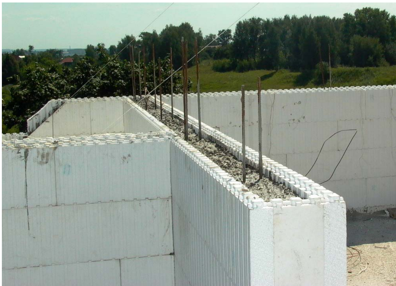
Рис. 4. Вид несъемной опалубки из пенополистирола
