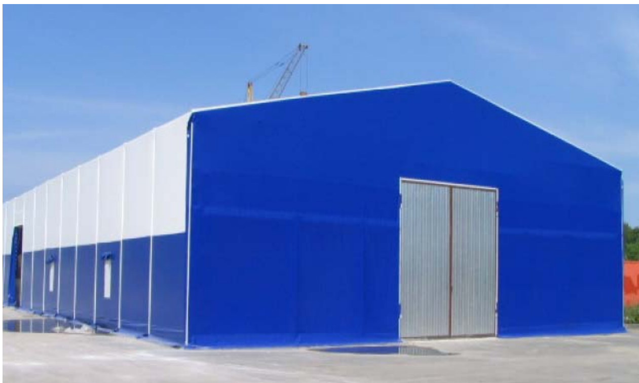
Рис. 3. Вид каркасно-тентового складского сооружения
