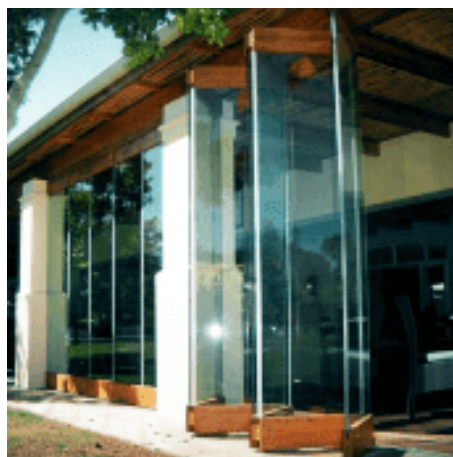
Рис. 3. Безроликовый нижне-опорный тип подвеса
