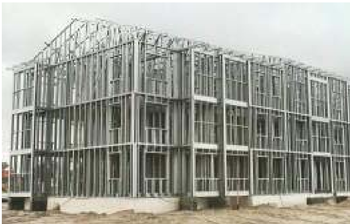
Рис. 1. Вид каркаса малоэтажного дома из ЛСТК
